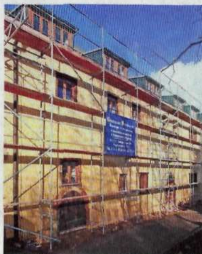
Die Musikschule ist Baustelle.
